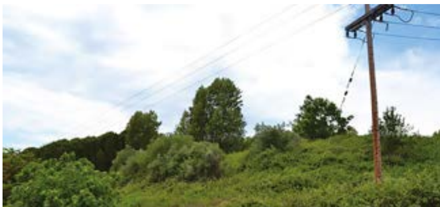
Κοντινή λήψη των φυτεύσεων και της πυκνής βλάστησης που έχει αναπτυχθεί στο ανάχωμα
